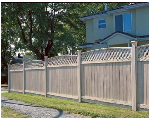
顶档的优美曲线和网格减少了这个栅栏实心封板的用量。
