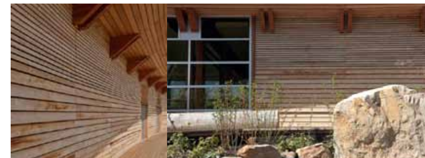
壁下部のシダー製クラディング詳細
