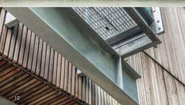
日光可充分射入室内，裸露的木材结构可让师生们产生一种亲切和熟悉的感觉。西部红柏垂直板条的雨幕墙漆系统（固定于西部红柏压缝条之上，而不采取压力处理）以天然环保的方式完成，使建筑能够逐步风化，品质优于周围的树木。
